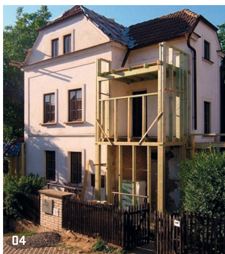
04, 05 > Realizace přístaveb s difúzně otevřenou dřevěnou konstrukcí
