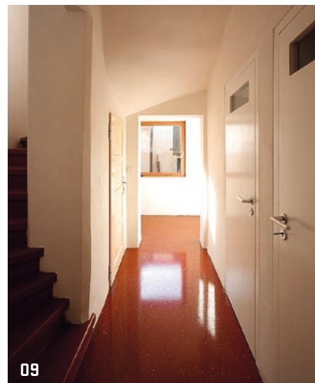
09 &gt; Podlahy jsou opatřeny epoxidovým nátěrem s barevným vsypem a lakem
