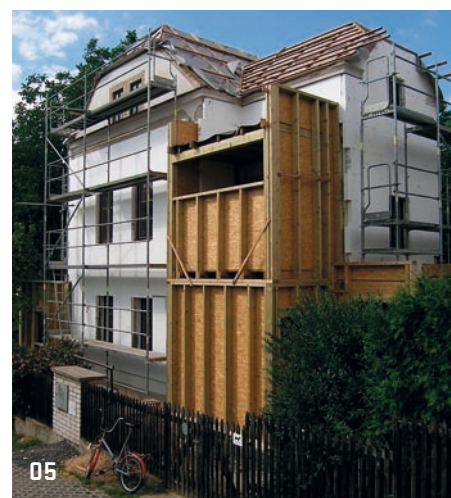
04, 05 > Realizace přístaveb s difúzně otevřenou dřevěnou konstrukcí
