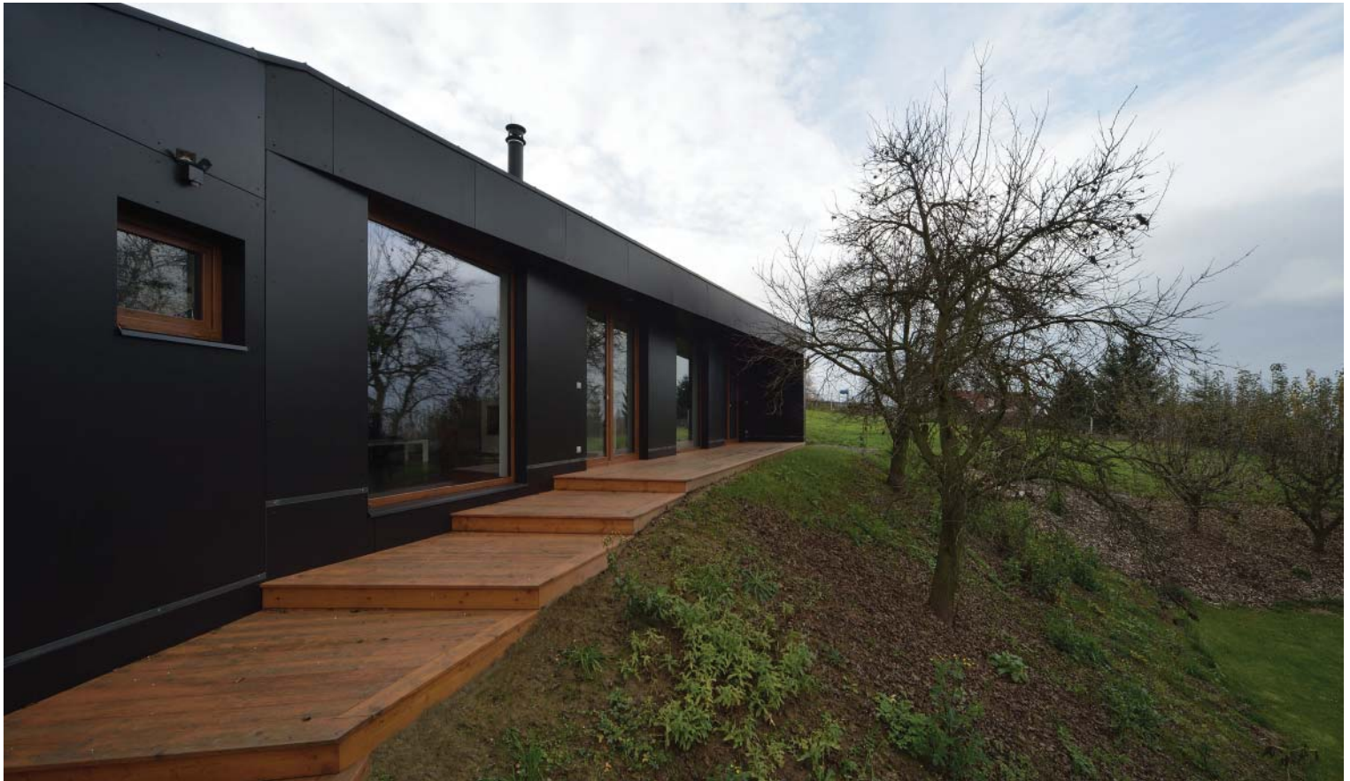
Nízká podlouhlá hmota přístavby kopíruje mírně se zvedající terén zahrady, schody se kromě haly objevují i na venkovní terase.
