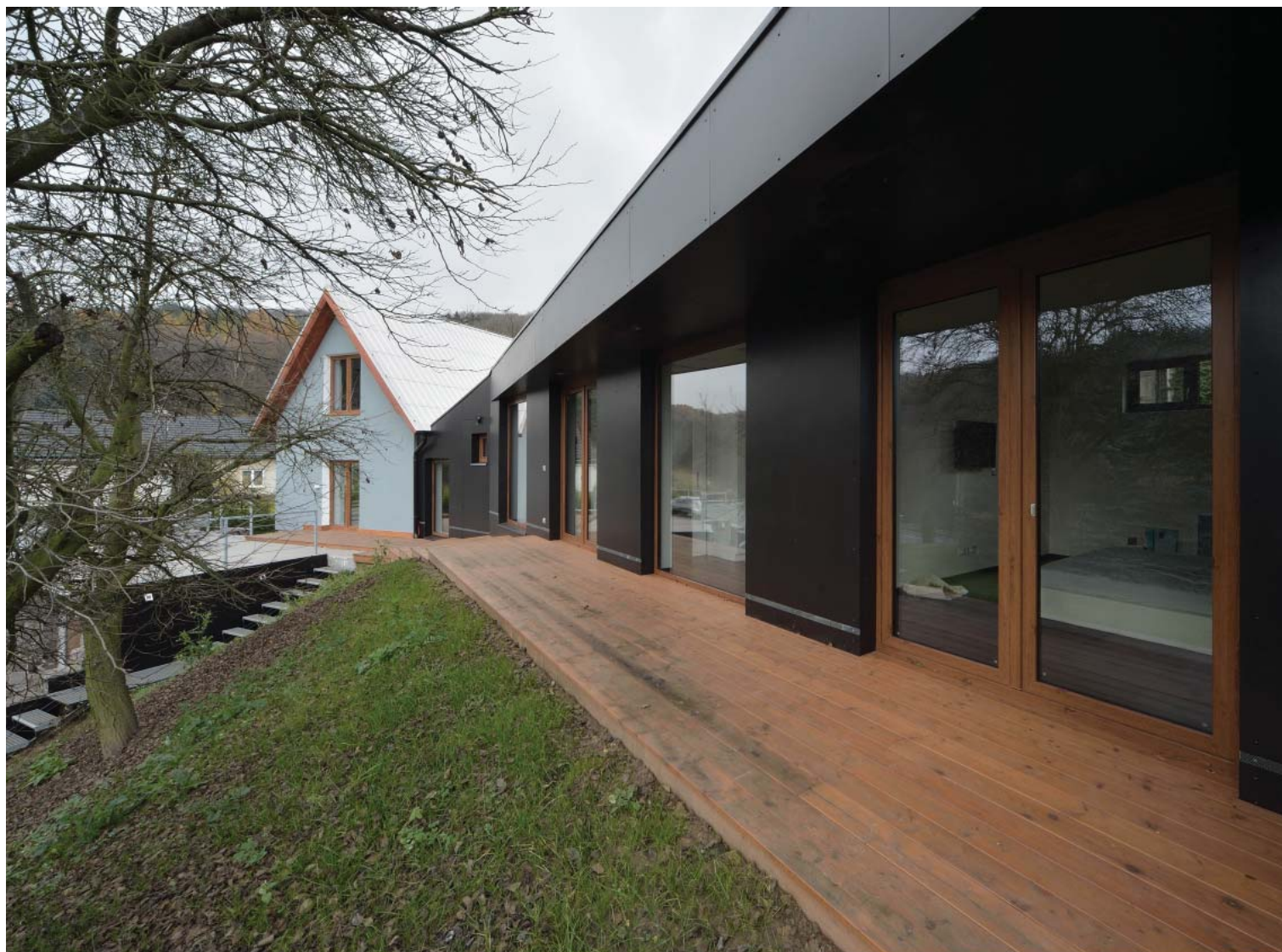
Přístavba je ve viditelném kontrastu k původní stavbě; čelní fasáda je členěna velkoformátovými okny, dřevěná paluba je kryta přesahem ploché střechy.
