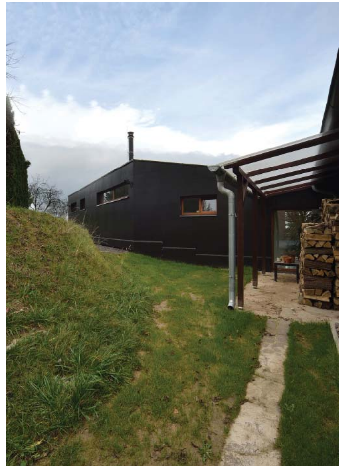
Zadní fasáda přístavby je prolomena pouze pásovými okny v horní úrovni.
