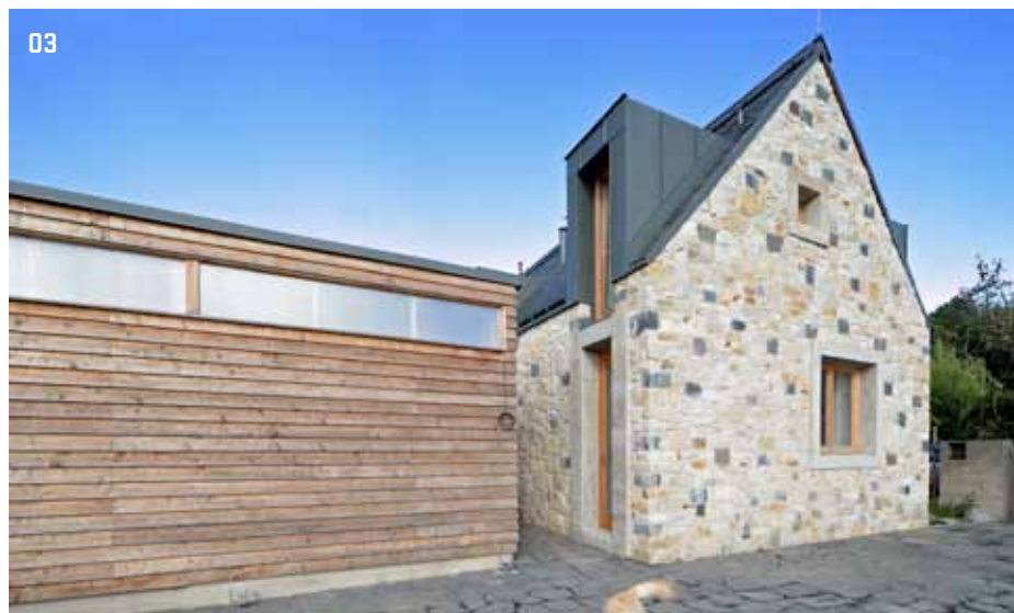
03 &gt; Dvůr před domem přechází v sad - vymezuje ho dřevěné hospodářské stavení
