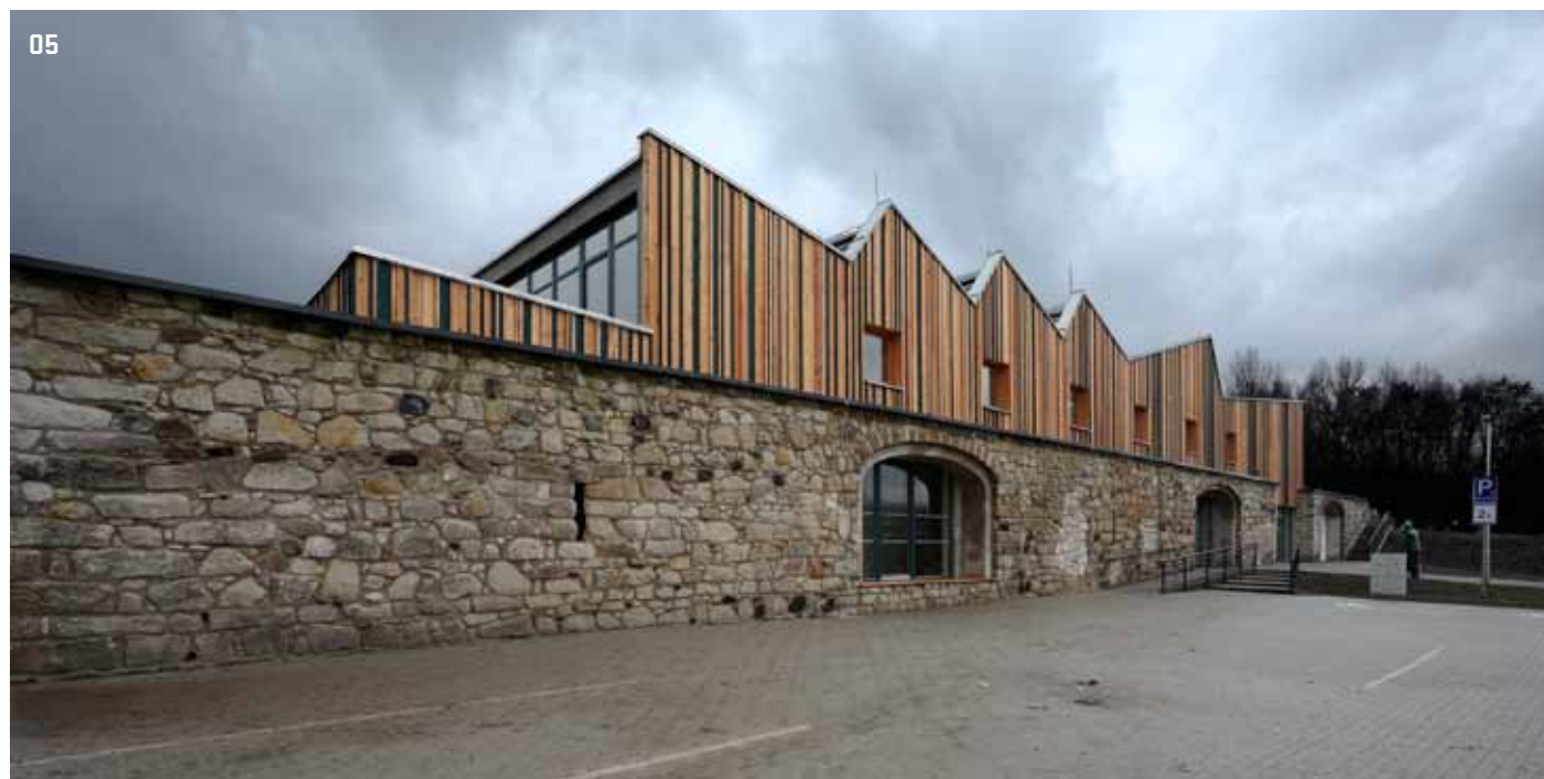
05 > Delší obvodové kamenné zdi původní stodoly slouží jako přirozené opěrky v terénním zlomu – zvláště na severní straně tvoří stabilní a pevnou fasádu domu
