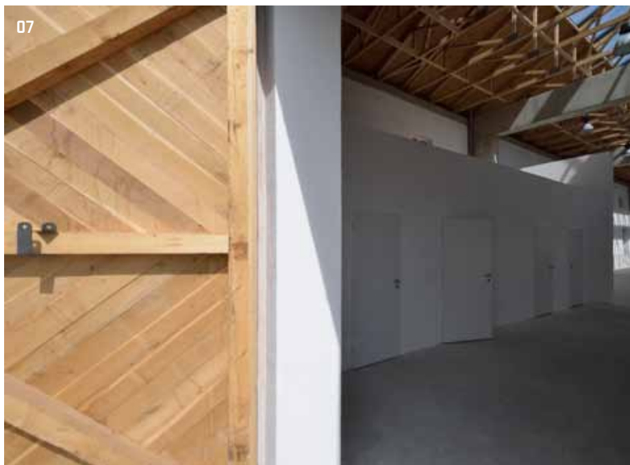
07 > V jižní fasádě konírny jsou nová vrata, která dobře zapadají do velkorysého interiéru s otevřeným krovem střechy
