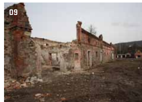
09 > Konírna před rekonstrukcí
